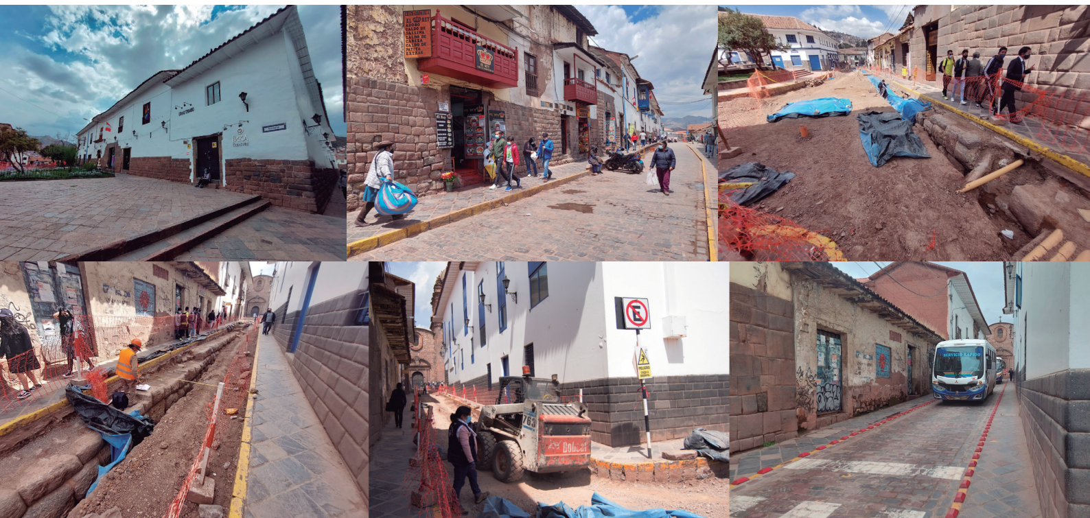
Figura 9. Calle Zetas. Hallazgos de muros incas bajo la superficie de rodamiento de la vía, posterior enterramiento y ulterior habilitación para la circulación vehicular.
