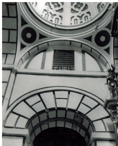
Figura 3. Interior de la Iglesia de San Francisco El Grande, Lima. Se aprecia un sector de las pechinas y la cúpula
