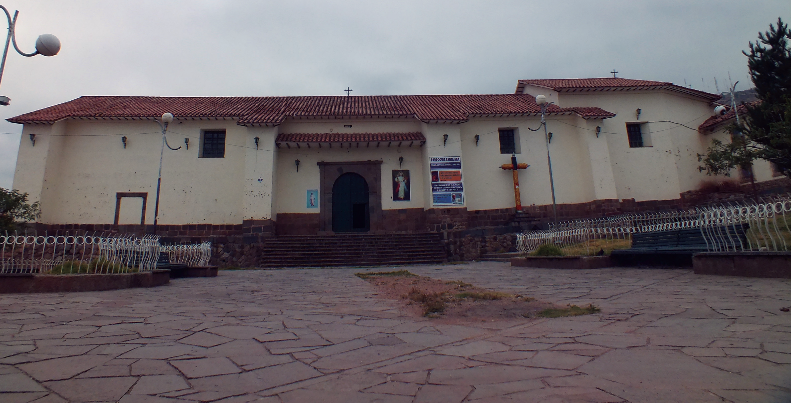
Figura 23. Templo de Santa Ana después de la intervención
