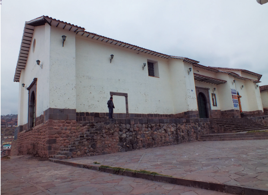
Figura 18. Templo de Santa Ana después de la intervención (volumetría recuperada)
