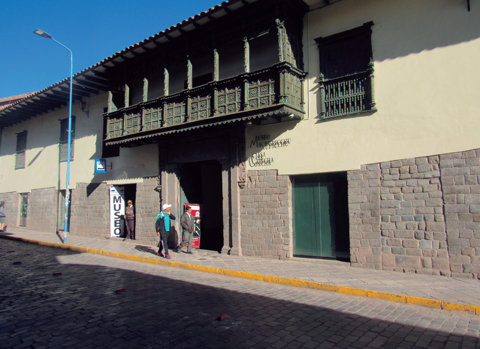
Figura 2. Vista de la fachada de la Casa Concha
