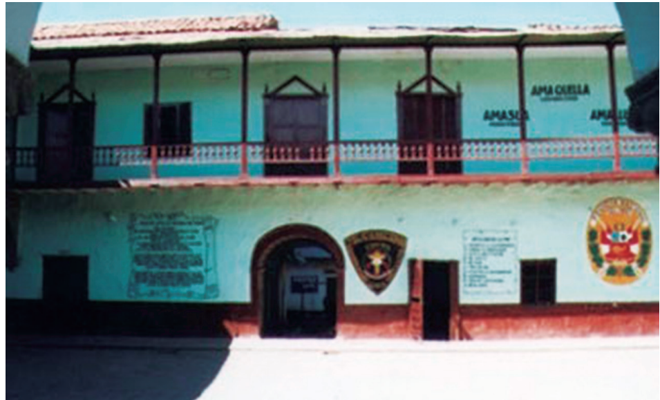
Figura 4. Vista del primer patio antes de la intervención
