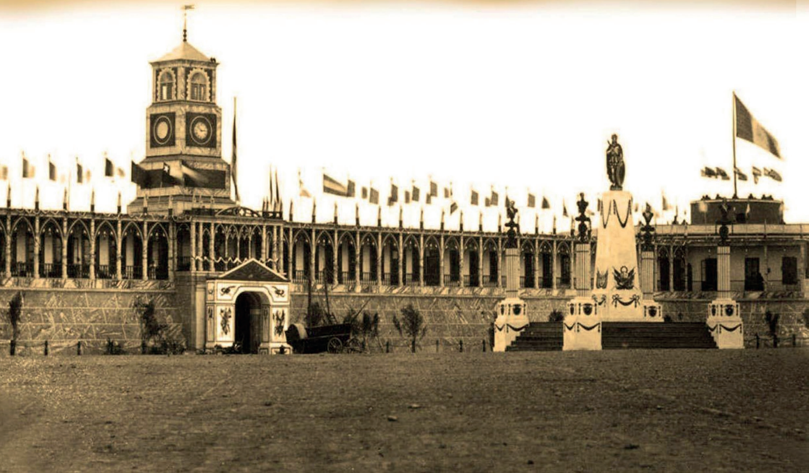
Figura 10. Castillo de la Independencia en 1865, se puede apreciar la galería de la aduana sobre la muralla, la torre del reloj y el caballero del baluarte del Rey antes de que su segundo nivel fuera demolido. Adaptado de El Castillo de la Independencia (1865), por R. Gonzales, 2018, El Callao que se nos fue. https://www.facebook.com/EICallaoQueSeNosFue/photos/a.692295160839222/1561788723889857/?type=3&theater .
