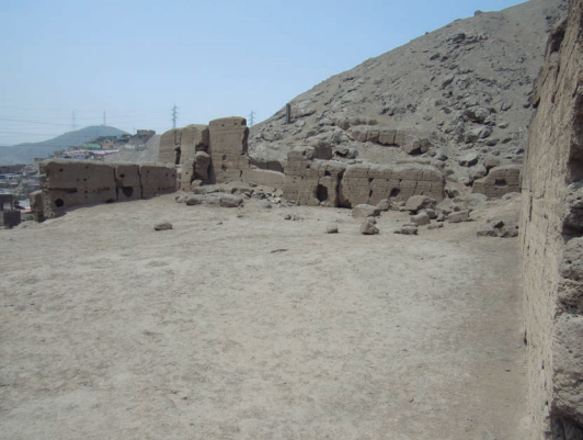
Figura 6. Vista del atrio perteneciente al edificio monumental del sitio arqueológico Huaca Fortaleza de Campoy. Archivo fotográfico de José Bazán Castillo, 2018.
